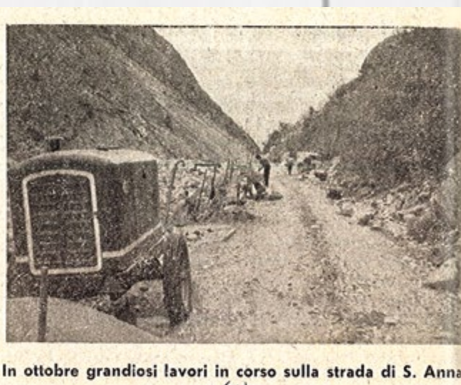
In ottobre grandi lavori in corso sulla strada di S. Anna.
